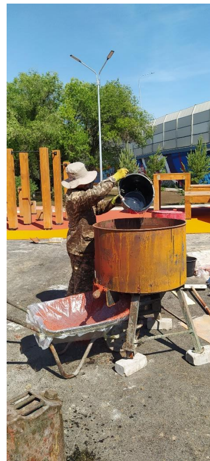
Рисунок 8 – Процесс приготовления резинового покрытия
