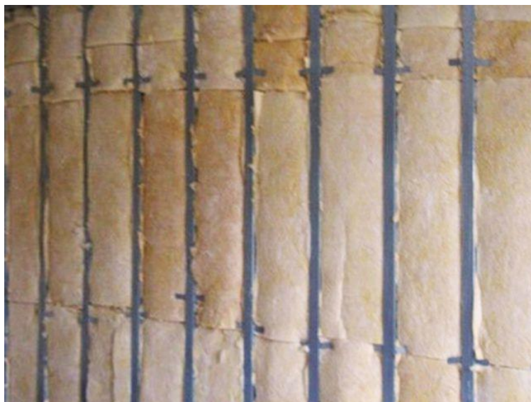
Рисунок 18 – Закрепленные стойки на прямые подвесы по минеральной вате
