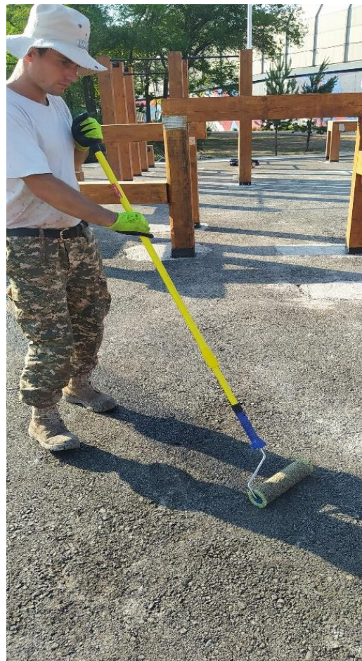
Рисунок 6 - Нанесение грунтовочного состава
