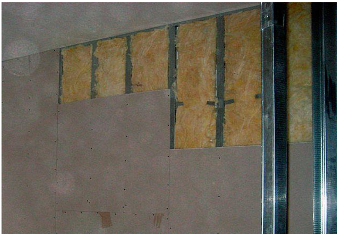
Рисунок 20 – Фрагмент облицованной стены гипсокартоном по металлическому каркасу с утеплителем
