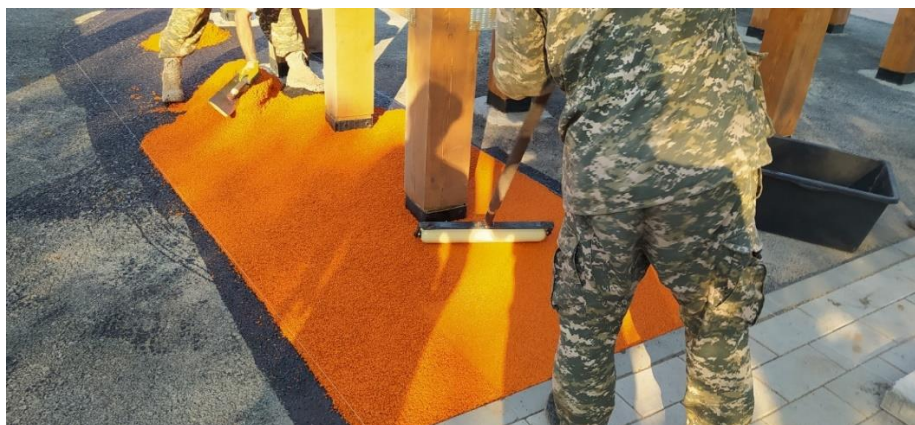
Рисунок 11 – Устройство резинового покрытия
