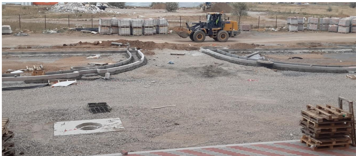
Рисунок 11 – Укладка дорожных бортовых камней
