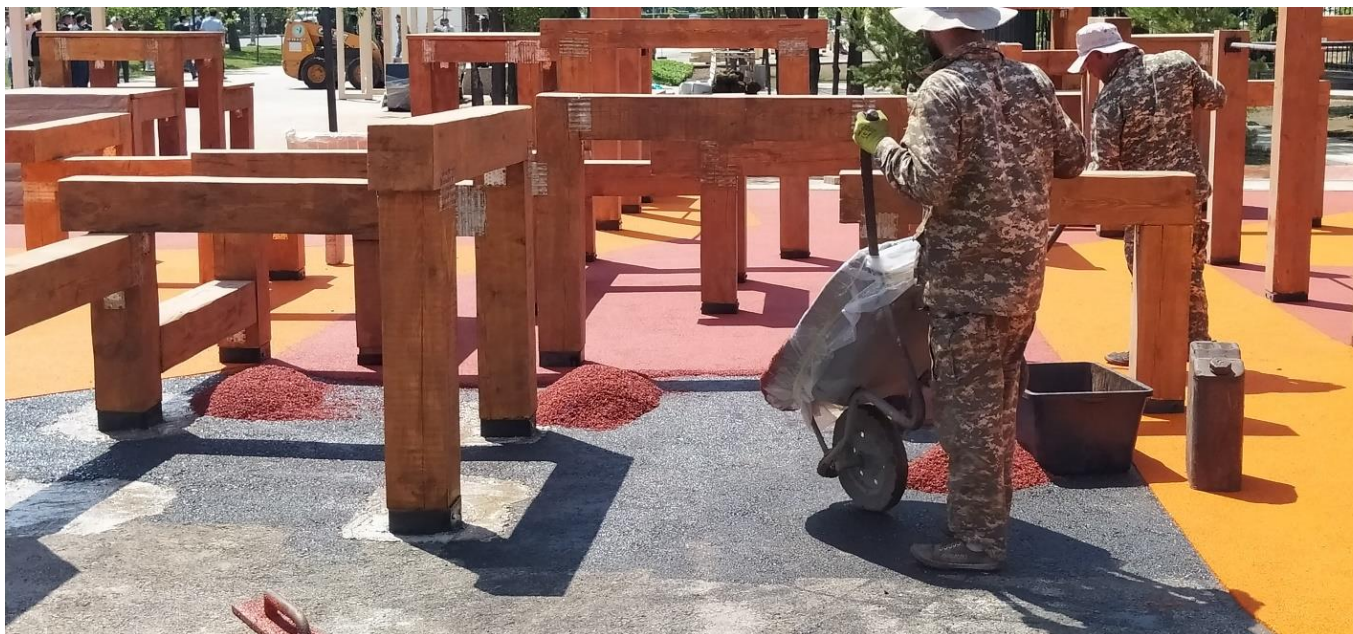
Рисунок 10 – Высыпка материала на основание
