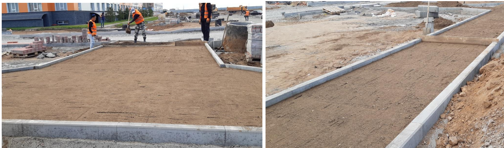
Рисунок 16 – Устройство верхнего монтажного слоя основания из песка
