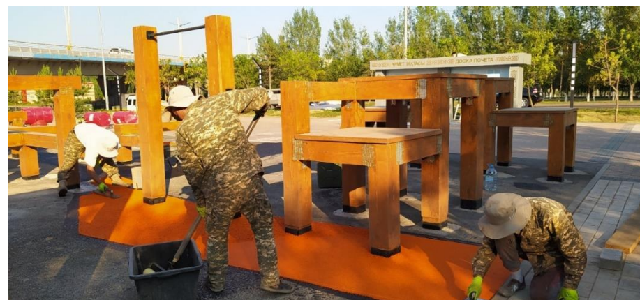
Рисунок 11 – Устройство резинового покрытия
