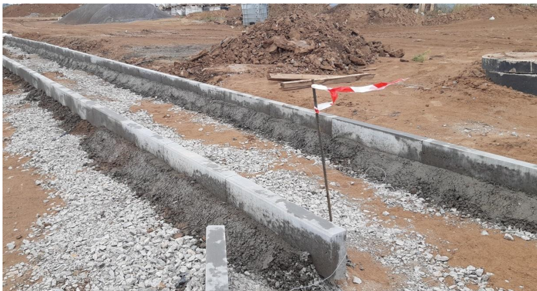
Рисунок 12 – Укладка поребрики
