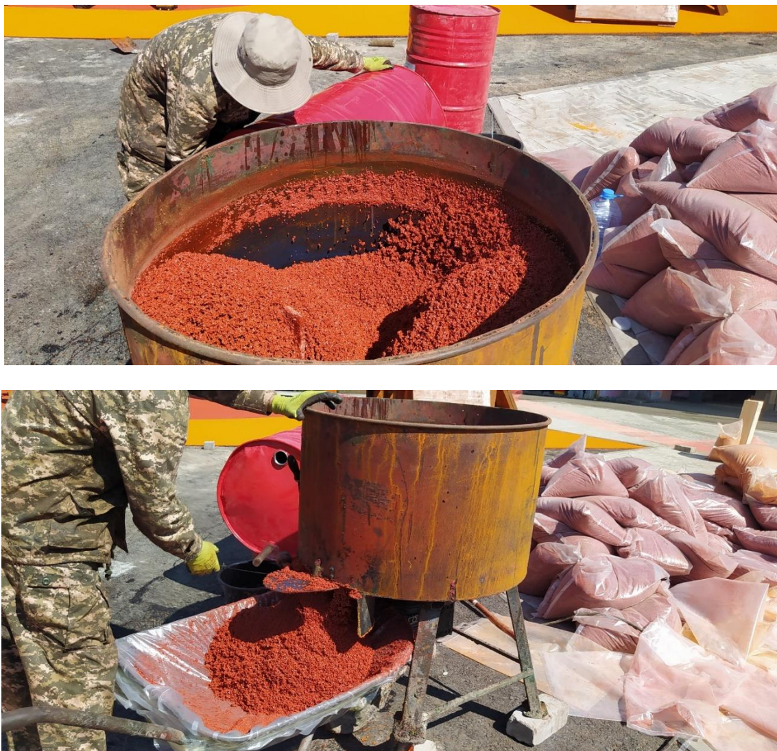
Рисунок 9 – Перемешивание и выгрузка материала резинового покрытия
