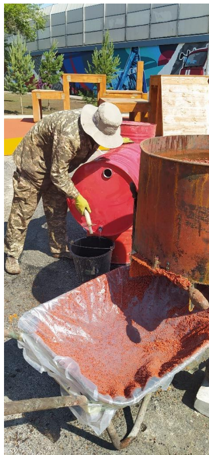
Рисунок 8 – Процесс приготовления резинового покрытия
