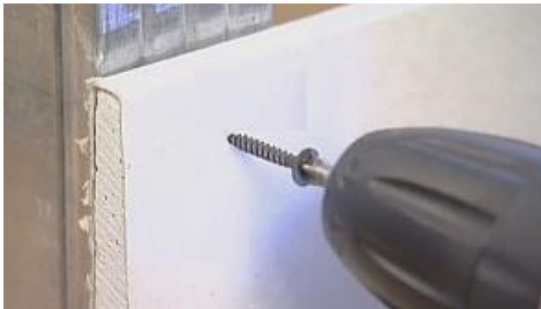
Рисунок 19 – Крепление гипсокартона к профилю саморезами
