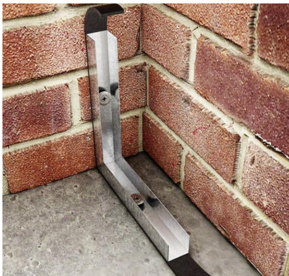
Рисунок 13 – Крепление направляющего профиля к полу
