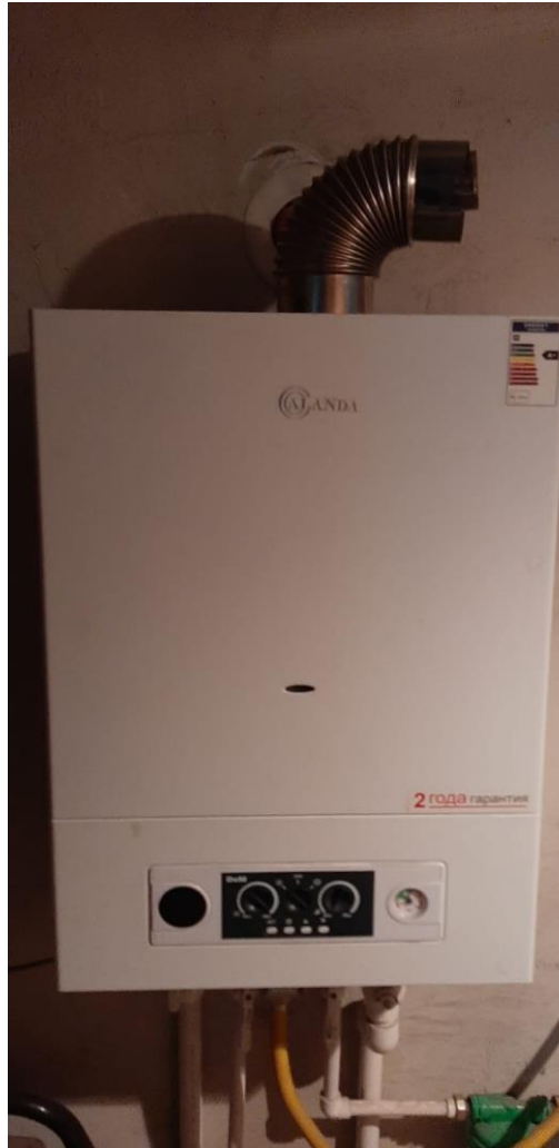
Рисунок 6 – Общий вид отопительного настенного газового котла
