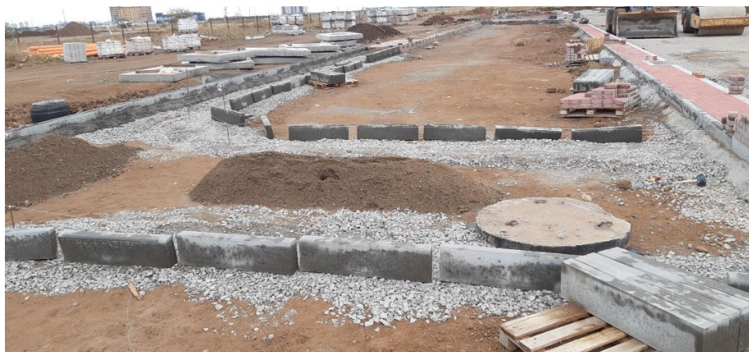
Рисунок 11 – Укладка дорожных бортовых камней
